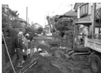
浦安市建設協会による 下水管の応急復旧作業
