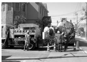
東京都下水道局による 下水管内の土砂除去作業
