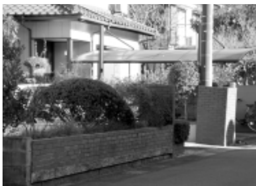
写真 6.2 液状化によって傾いた美浜区磯部7丁目の住宅の門
