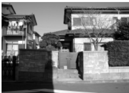
写真 6.2 液状化によって傾いた美浜区磯部7丁目の住宅の門
