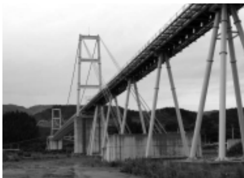
04 土砂運搬用の巨大なベルトコンベア(陸前高田市)
