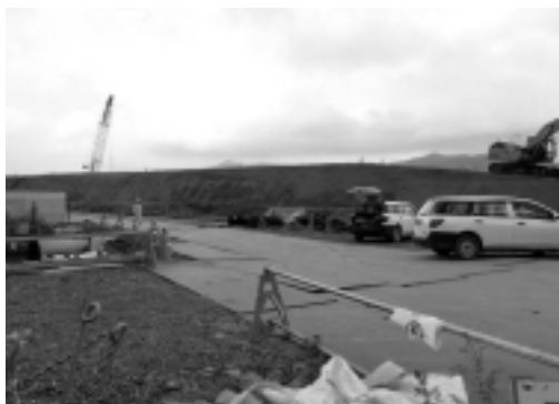
07 海岸防潮堤工事(宮古市)
