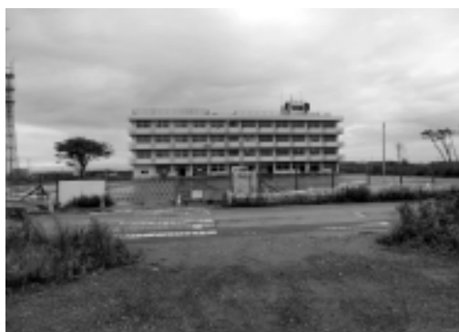
写真 6.3 仙台市立荒浜小学校 海拔2m
