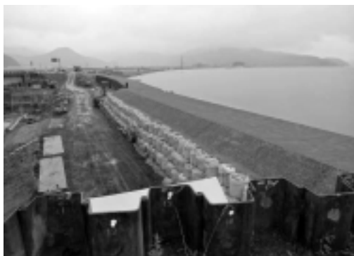
03 北上川、新北上大橋上流堤防修復工事(石巻市)
