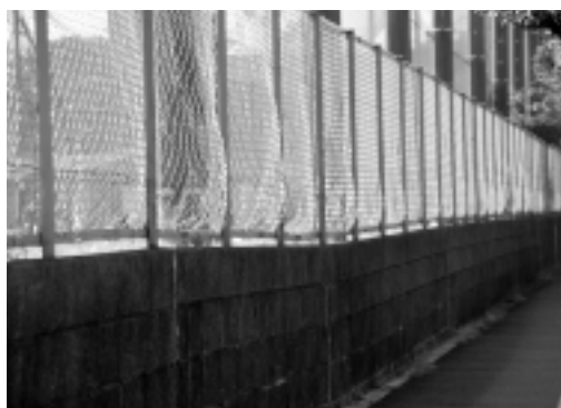
写真 6.1 液状化でゆがんだ千葉市立稲毛高校のグラウンド周囲のフェンスとブロック塀
