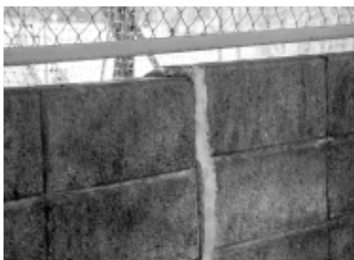
写真 6.1 液状化でゆがんだ千葉市立稲毛高校のグラウンド周囲のフェンスとブロック塀
