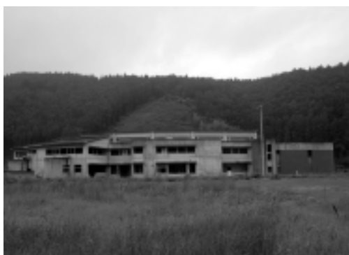
写真 6.4 石巻市立大川小学校 海拔1m
