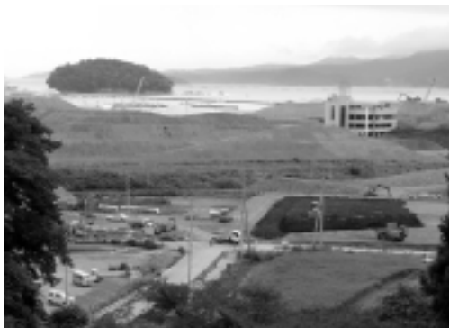
南三陸町戸倉地区。海岸低地の盛土嵩上げ整備が行われている。
