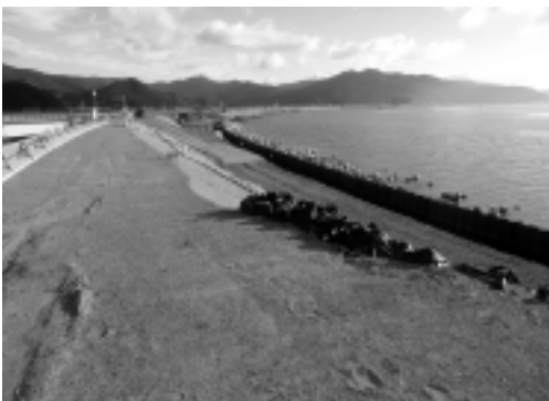
北上川新北上大橋上流堤防修復工事
