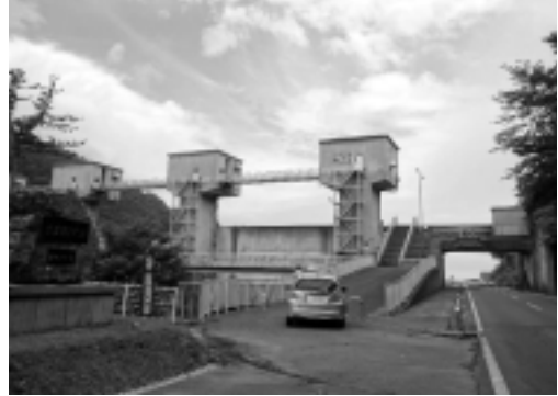
写真10 普代水門(2016年8月3日撮影)
