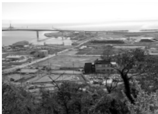
石巻市門脇地区、南浜地区の津波被災地区。盛土嵩上工事。(2015年11月撮影)
