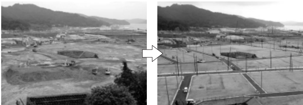
写真4 大槌町被災市街地では復興整備・地盤の嵩上げ整備が進む (左 2015年8月撮影 右 2016年8月撮影)
