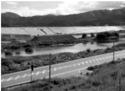
写真7 陸前高田の防潮堤防施工(二線堤)高さT.P + 12.5m計画 堤防に閉ざされて陸側から海が全く見えなくなる。(2016年8月撮影)
