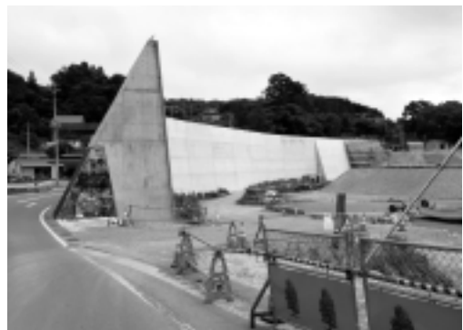
大船渡市細浦地区の堤防整備 既存堤防(黒い部分)を増強(2倍以上の高さ)で建設
