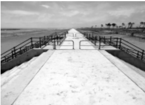
仙台市荒浜海岸堤防
