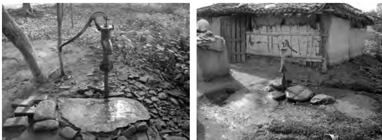
写真5 テライ・ナワルパラシの集落における手押しポンプ管井戸の例 左：パトカウリ集落 右：ダウガウ集落
