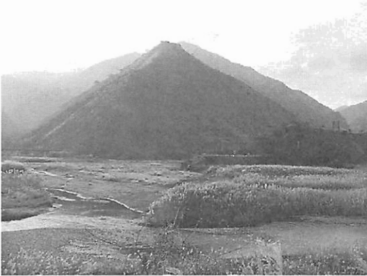
写真1 渡良瀬川（松木川）と久蔵川の合流部 はげ山での砂防・植林が進む。足尾砂防ダム上部深谷は土砂の堆積で平坦化している
