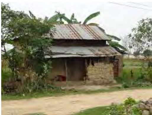
トタン屋根, 土壁の家
