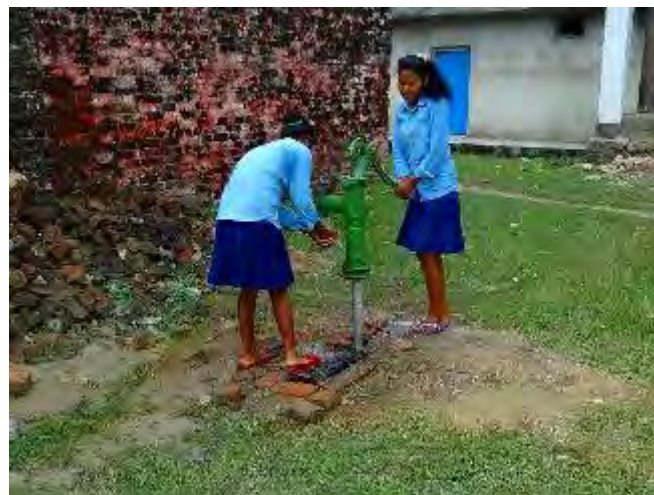
写真 6.4.6 安全な水の確保として行った事例 2014 年 8 月に我々調査チームが掘削設置したヒ素のない井戸．深さ 35m掘削し，ポンプを取り付けて学校へ寄付した（コカプルワの学校の校門前に設置）.
