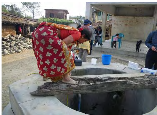
コカプルワ Khokharpurwa 飲用に利用されている掘り井戸。足場が悪い状態で水を汲む女性。表面はコンクリートで修復されている。蓋はされていない。
