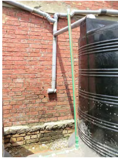
写真 6.1.3 初期降水除去装置
