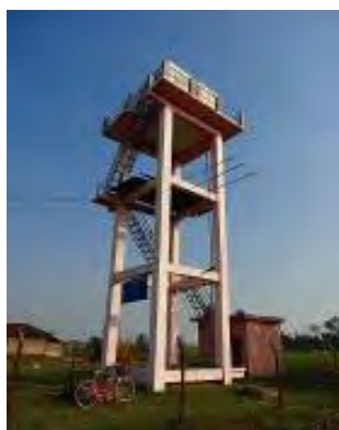
写真 5.3.1 水道用給水塔 （ゴイニ Goini）
