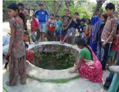
写真 5.3.4 煉瓦積の伝統的掘井戸 (コティラハ Kothiraha)
