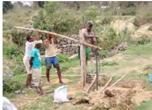
写真 4.3.2 堆積物採取のための掘削調査
