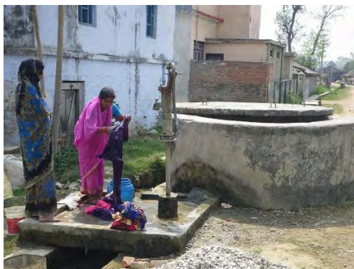
マフワ Mahuwa 共同の掘り井戸。パイプを挿入して手押しポンプで汲み上げ利用する。洗濯や農具など荒い物に利用される。
