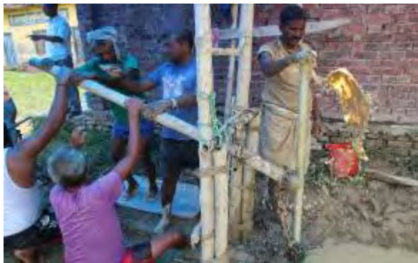
写真 4.3.3 堆積物採取のための掘削調査
