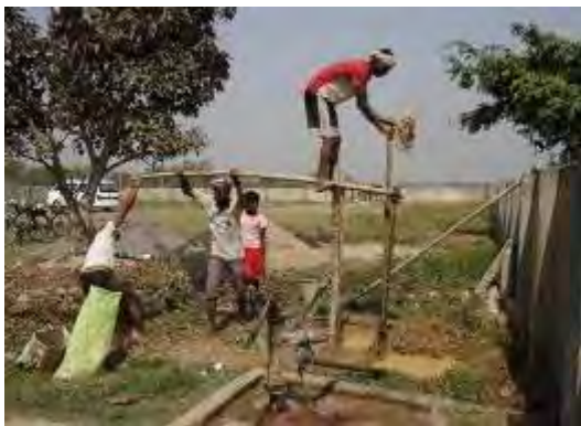
写真 4.3.1 堆積物採取のための掘削調査
