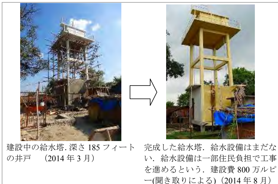
写真 6.4.1 マフワ Mahuwa に建設中の給水塔
