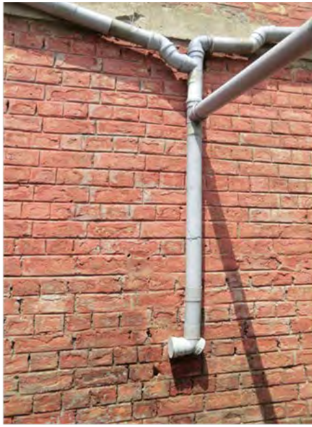
写真 6.1.2 初期降水除去装置と水位計
