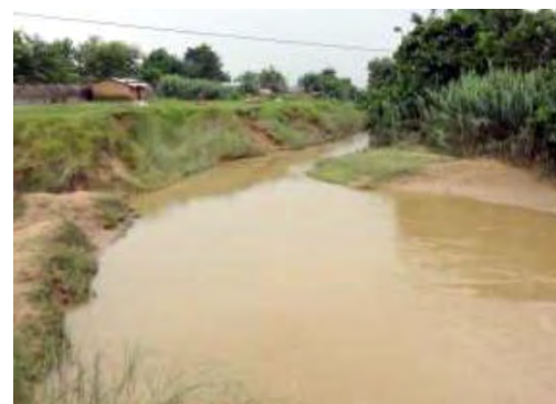
写真 4.2.11 河川の河床堆積物はシルト・粘土で砂やレキはほとんど確認できない
