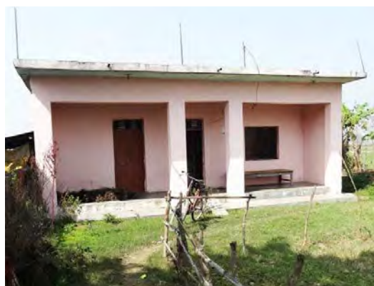
写真 5.1.2 レンガにモルタル、ペイント塗装したバフンの住居
