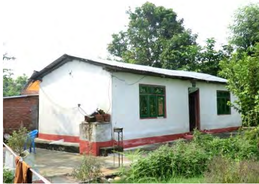
住宅 A. トタン屋根の家屋住宅
