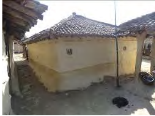
竹と土を使った壁の伝統的家屋. 屋根は素焼きの瓦. 伝統的家屋は窓が小さい.
