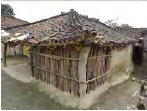
細い丸太を利用した壁. 入り口部分に設けられている. 住居部分は土壁,瓦屋根
