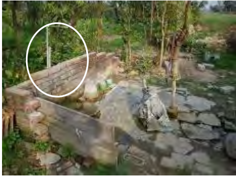
写真 5.3.3 山麓の伏流水からパイプで引水されている水道 (スリヤプラ Suryapura)
