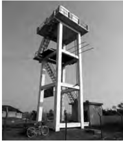
写真 1 水道用給水塔 ゴイニ(図3の㉔)
