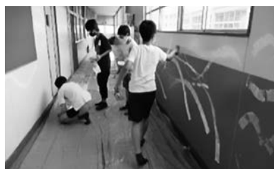
図3 ローラーで下塗り
