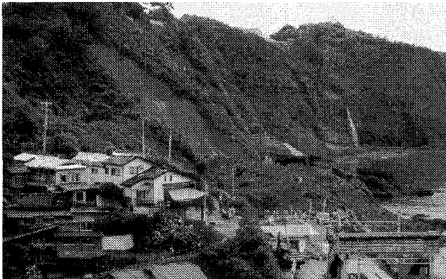
1. 青海川駅土砂災害。崖崩れで信越線青海川駅線路が埋まる。この辺の家は地震で屋根瓦が落ちていたところが多く、ブルーシートで屋根を覆っている。
