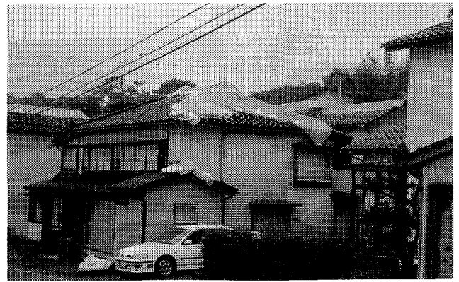
4. 鯨波地区。鯨波地区は倒壊が少ないが、屋根瓦が落ちたり剥がされた家が多い。
