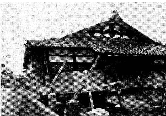
27. 傾いて倒れかかった成願寺（西本町）. 丸太で支えている. この辺りは寺が多い.
