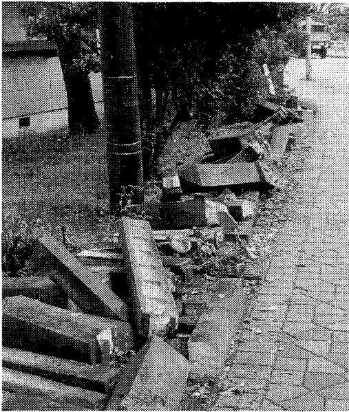
23. 柏崎神社周囲の石塀（柵）. 全部倒れている.
