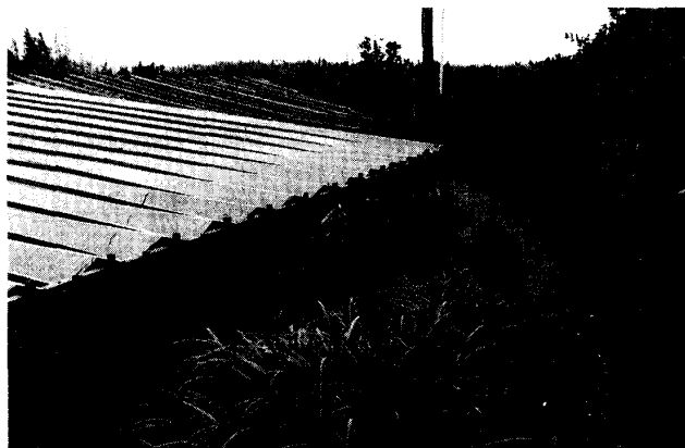
図14 洲の崎半島の西端、伊戸（いと）におけるベニバナ栽培の温室。強風にも耐える独特の構造。温室群を囲んでさらに厚い防風垣がある（1998年6月7日）
